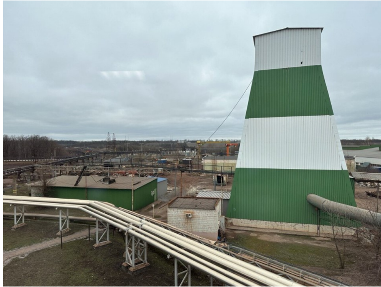
Второй ствол используется для спуска и подъёма людей и длинномерных материалов. Первый и второй ствол – воздухоподающие
