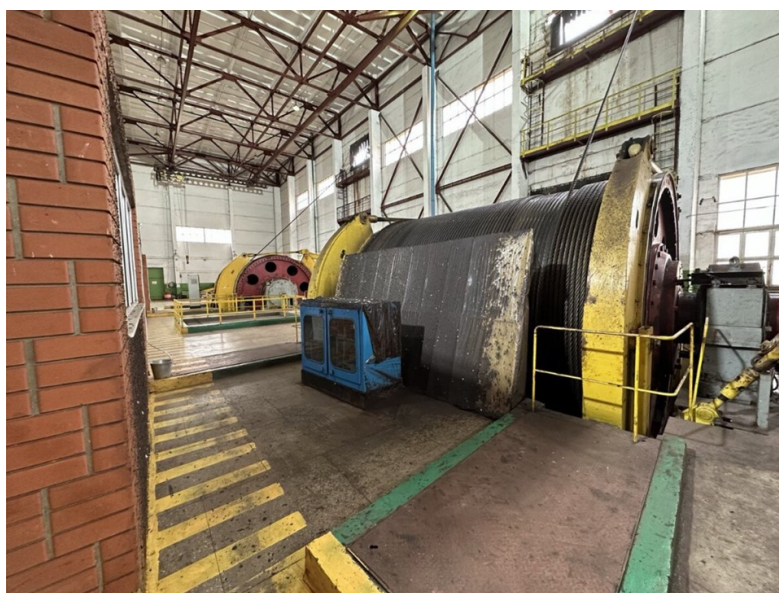
Ствол №1 шахты ЯГОКа. Он служит для спуска и подъёма работников, техники и выдачи на-гора железной руды
