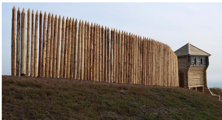
Башня и частокол на валу
