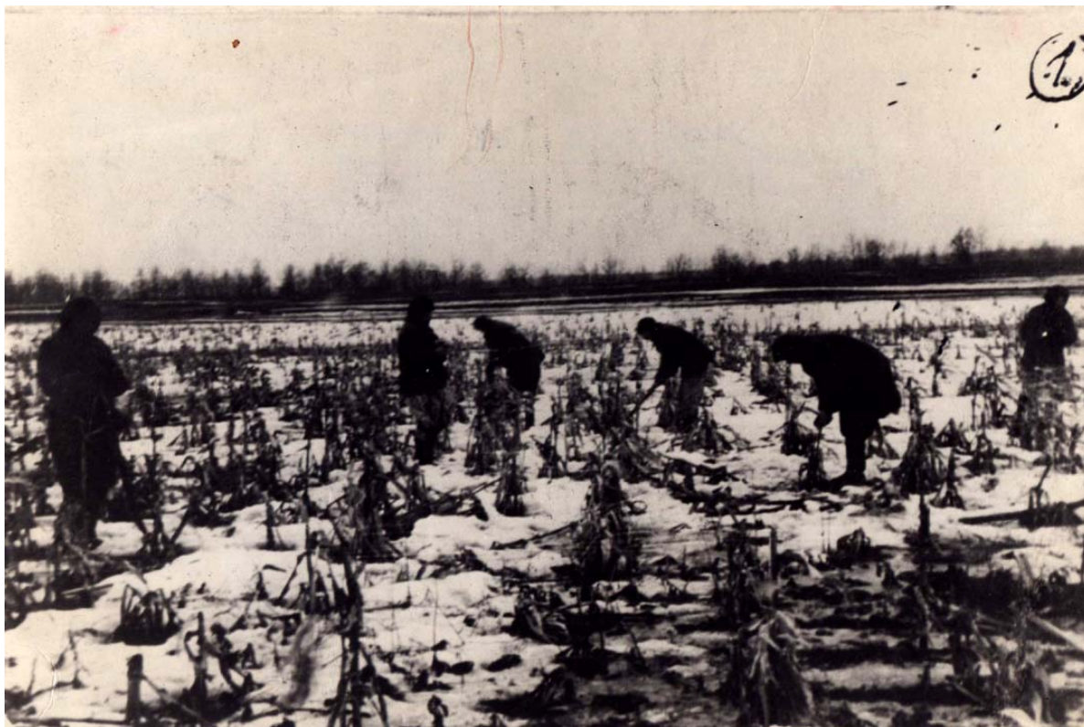
Расчистка поля под строительство первых зданий Из фонда историко-краеведческого музея Яковлевского городского округа
