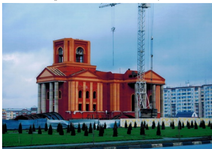
Строительство нового храма в г. Строитель, 2009 г.
